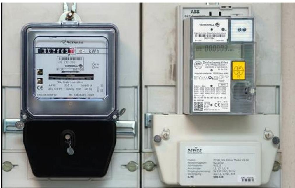
Abbildung 1 Smart Meter<sup>1</sup>
